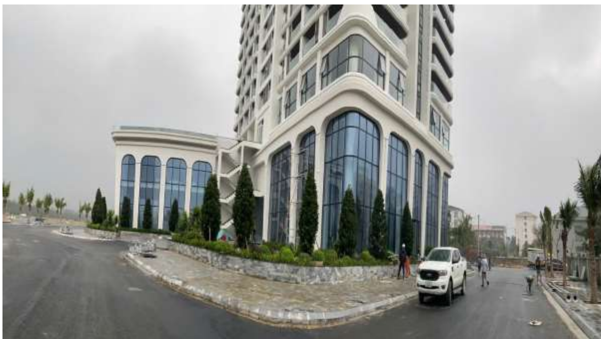
Hình 1.4. Hiện trạng khu đất của dự án
